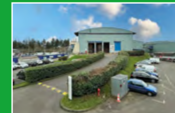
Usine de compostage
